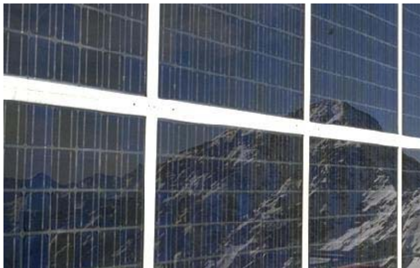
Façade photovoltaïque au Rothorn
